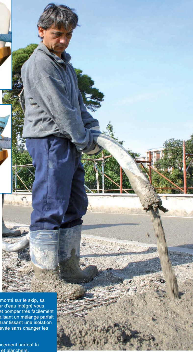
Charge de polystyrène perles
