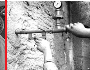
Iniezioni di boiaccia a pressione controllata
