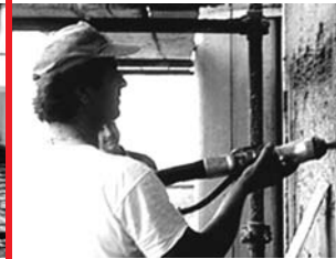
Applicazione di intonaco tradizionale o premiscelato
