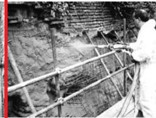
Spruzzatura di betoncino
