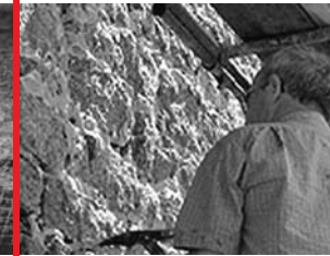
Riempimento giunti e connesure
