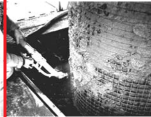
Spruzzatura di malta fibrorinforzata
