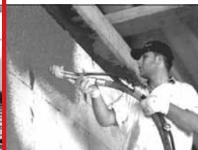
Projeção de reboco tradicional ou pré-misturado
