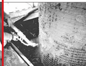
Projeção de argamassa especial reforçada com fibras para recuperação estrutural
