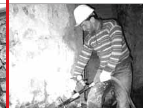
Injecção de calda de cimento sob pressão controlada
