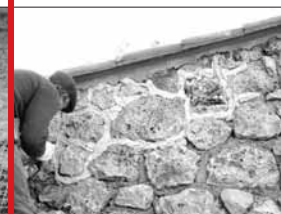
Graças à capacidade variável é possível o enchimento de juntas e conexões
