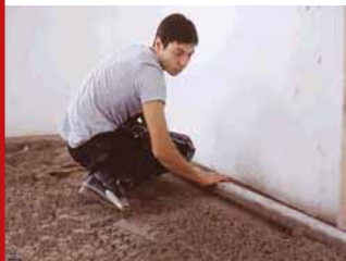
Colocação do contrapiso
