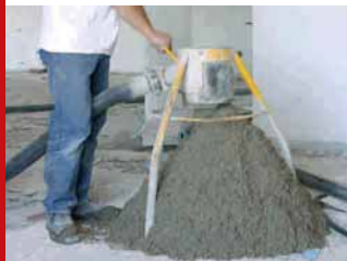
A mistura transportada para os andares superiores
